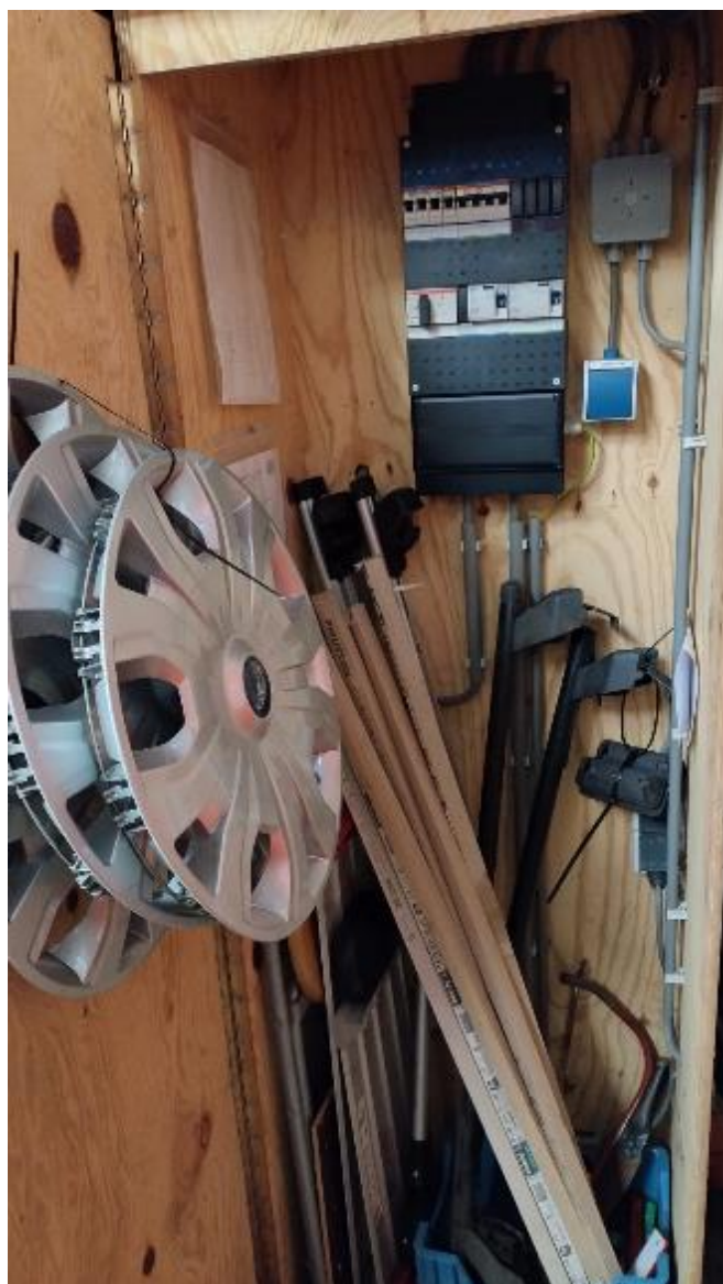
Foto 7: De meterkast dient vrij te zijn van spullen
